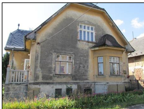
Bývalá četnická stanice v Liptani, č. 261.
